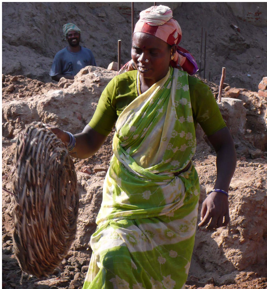
Løsarbejdere på byggeplads i Tranquebar.
